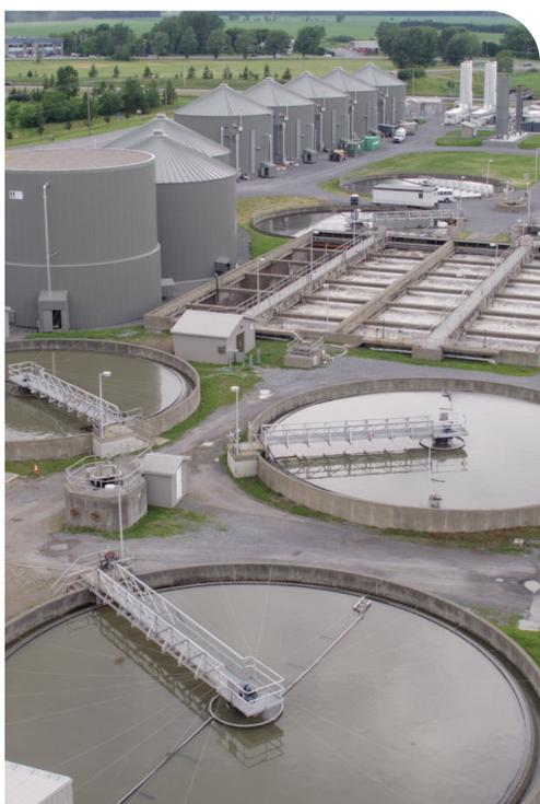
**Les eaux usées sont traitées en plusieurs étapes avant d'être rejetées dans l'environnement. D'abord, les déchets solides sont dégrillés, puis les matières en suspension sont décantées.**
