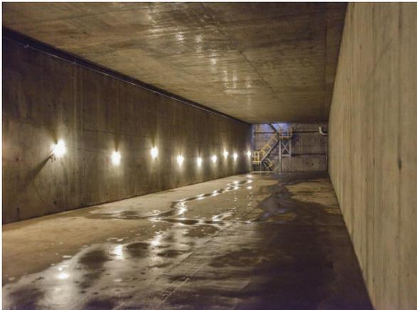
La capacité du réservoir Hertel-Cloutier est de 11 200 000 litres, soit l'équivalent de 4 piscines olympiques.
